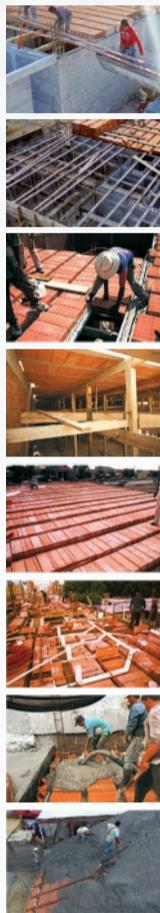
8. Si una vigueta se fisurara o rompiera por una caída, basta con colocar un fondo de triplay y puntal bajo la parte rota o fisurada y proceder con el colado.
